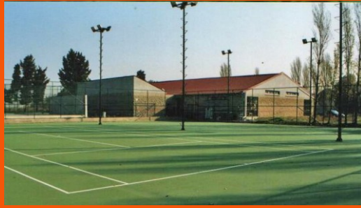
Proje : Y.T.Ü. Spor Kompleksi İşveren : Y.T.Ü. Yapılan İş : Tasarım ve İnşaat İşleri; Yer : Davutpaşa-İSTANBUL
